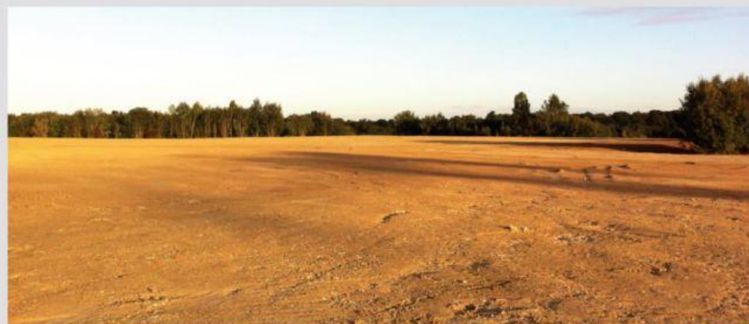
Plateforme après compactage. A droite, un îlot boisé, témoin de la biodiversité du site.
